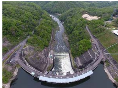
高山ダムフラッシュ放流実施状況 (ゲート点検も兼ねて35年ぶりに非常用ゲートで実施)
