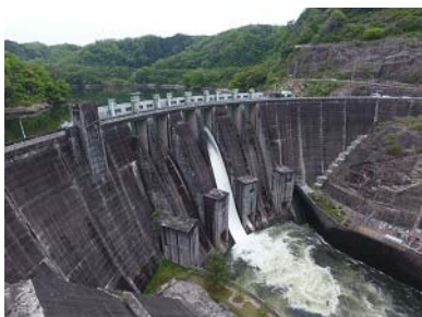
高山ダムフラッシュ放流実施状況 (ゲート点検も兼ねて35年ぶりに非常用ゲートで実施)
